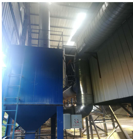
1#除尘器稳定土
