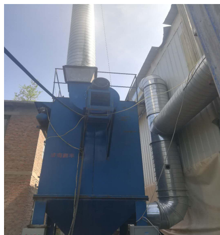
2#除尘器稳定土
